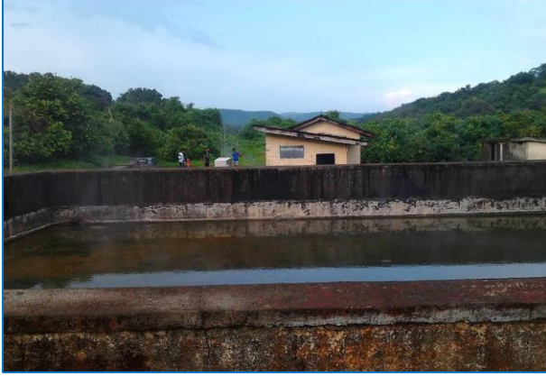
Unhavare Hot Water Kund
